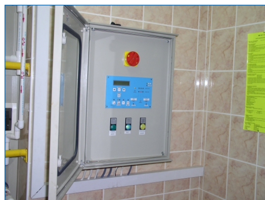
Sterownik stacji dozowania - panel sterowania i synoptyki
